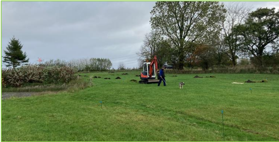
Vorarbeiten: Abstecken der Pflanzplätze, verteilen Pflanzmaterial.
